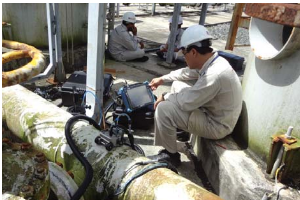
Hình 7. Đoạn đường ống khảo sát thực tế
