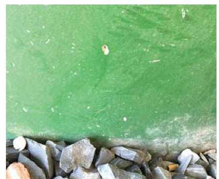
Hình 12. Đường ống nước làm mát Nhà máy Điện Nhơn Trạch 2
