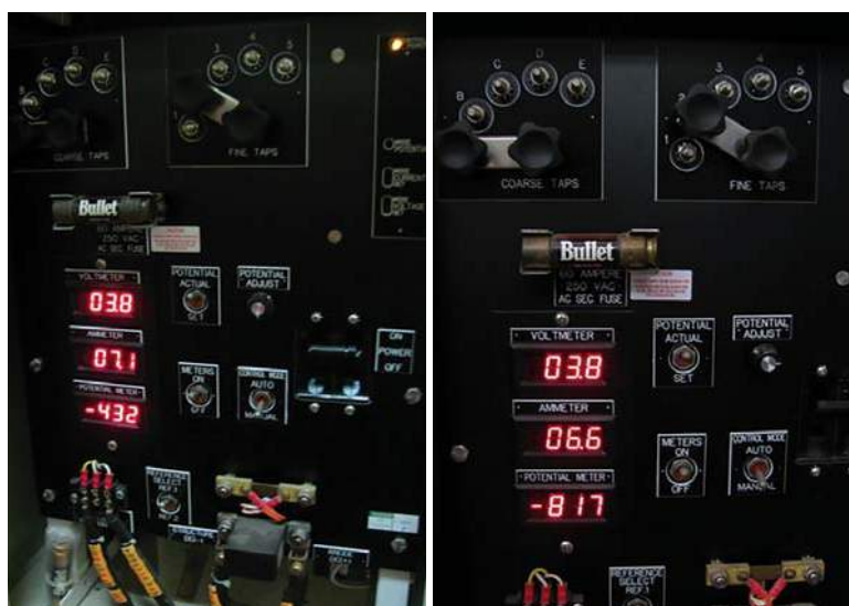
Hình 13. Điện thế bảo vệ cho đường ống nước làm mát Nhà máy Điện Nhơn Trạch 2
