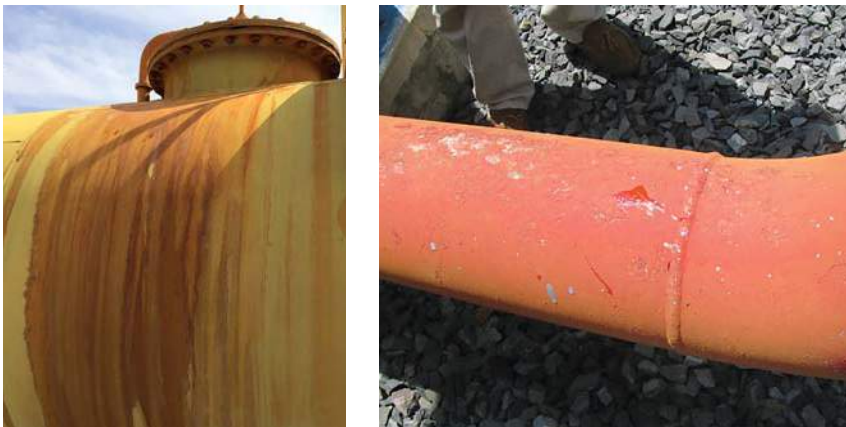
Hình 8. Bồn chứa HCl tại Nhà máy Điện Cà Mau 1
