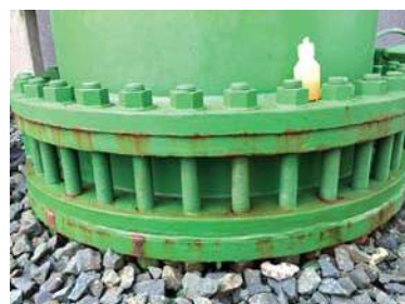
Hình 4. Đường ống nước làm mát khu vực Cooling Tower Điện Cà Mau 1
