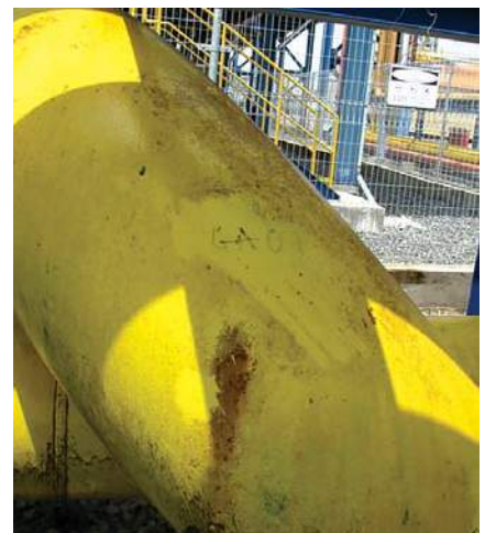
Hình 11. Đường ống dẫn khí
